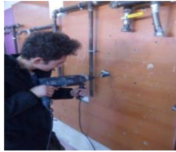
6.Şekil: Uygulamanın yapılması
