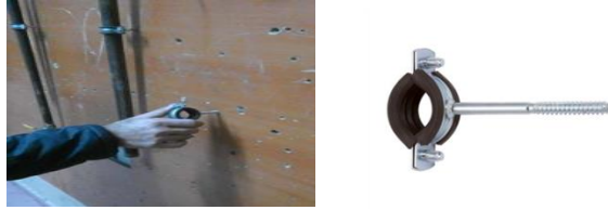
1.Şekil: Doğalgaz boru kelepçesinin elle sabitlenmesi.
